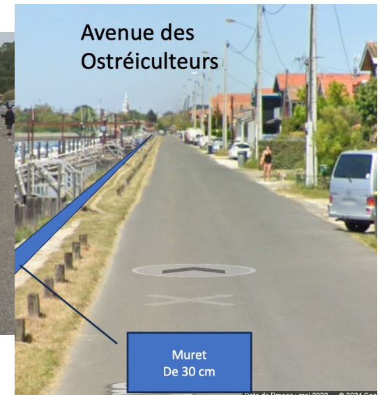
Murets anti submersion à Andernos
