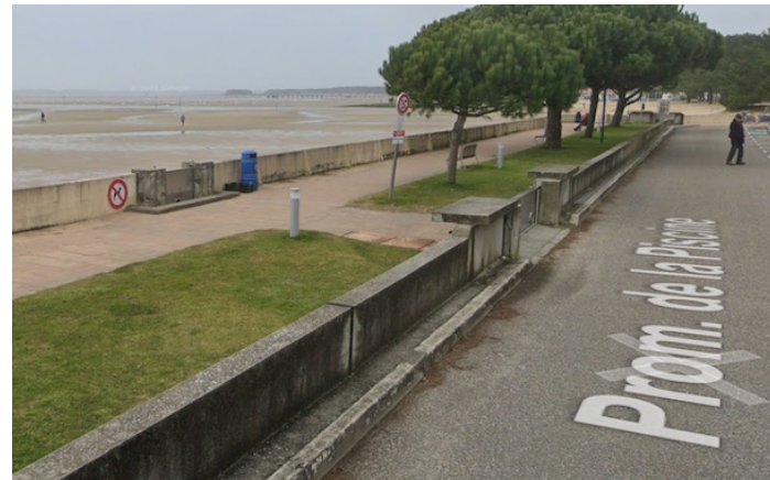
Murets anti submersion à Andernos
